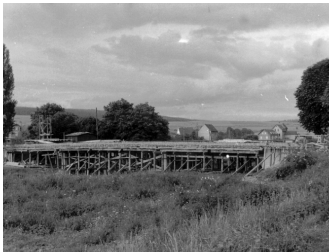
Bau der Spannbetonbrücke – 1953/54
