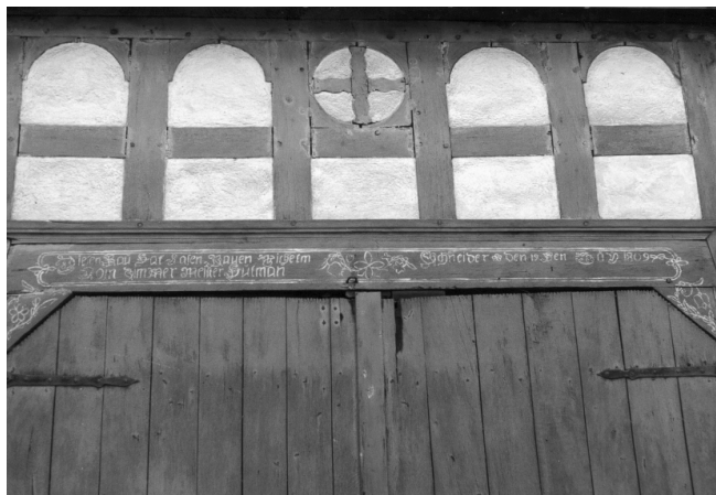
Hausinschrift am Torbalken der Scheune Hauptstraße 34
