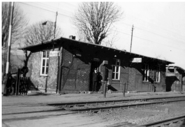
Bahnhof Werdorf um 1955 – der Übergang ist noch mit Holzschwellen gebaut
