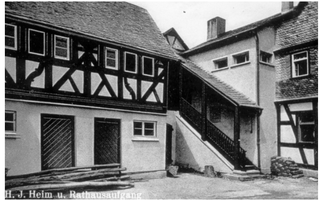
Treppenaufgang zum Bürgermeisteramt auf der Rückseite des Backhauses
