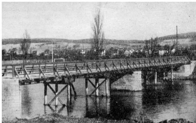
Holzbrücke auf den Pfeilern der im März 1945 gesprengten Eisernen Brücke
