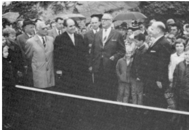
Verkehrsübergabe der neuen Dillbrücke – 1966
